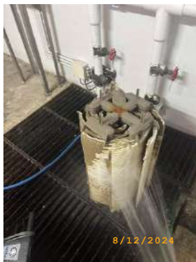
รูปที่ 2- 72 การทำความสะอาดเครื่องกรองน้ำ
