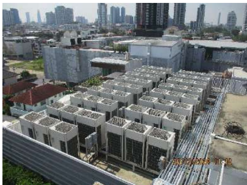
รูปที่ 2- 27 คอมเพรสเซอร์เครื่องปรับอากาศ
